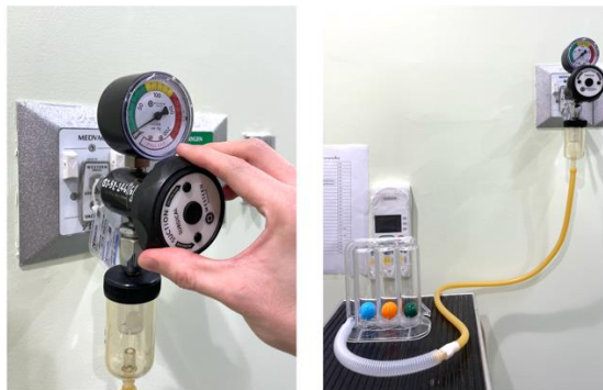
รูปที่ 4 เครื่องปรับความดัน Suction regulator with pipeline system (ซ้าย) และการต่อเครื่องปรับความดันลบเข้ากับอุปกรณ์ FIS (ขวา) (ภาพจาก: ปฏิพล ก้าวงามพาณิชย์ และ กรวิชญ์ ลิขิต)
